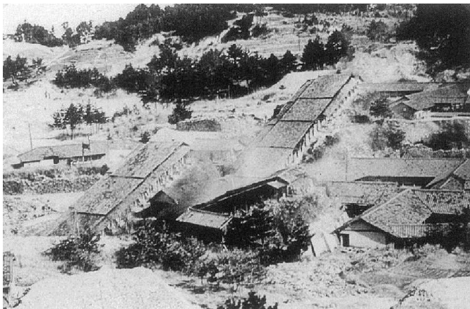
写真2-3 昭和21年頃の石州瓦の登り窯と窯出しの様子（左：江津市嘉久志町付近 右：江津市都野津町内） 『目でみる 石見の100年』より抜粋
