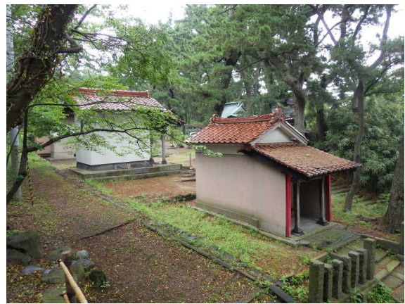
写真4-3-2 酒田市日和山にある石州瓦の社殿 (阿部撮影 2014年)
