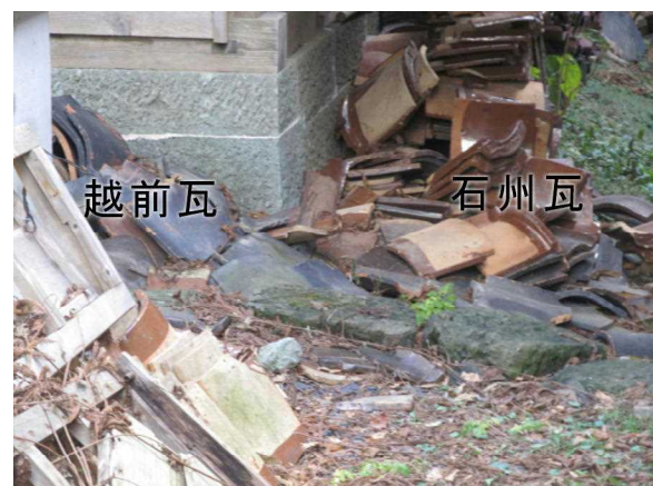
写真4-1-4 北海道松前町で見られる赤瓦の混ぜ葺き (松前町法華寺) ※色も形もサイズも違う異なる産地の赤瓦が同じ屋根に葺かれている 写真左は石州瓦と三州瓦 写真右は屋根から下ろされた越前赤瓦と石州瓦 (阿部撮影 2013年)
