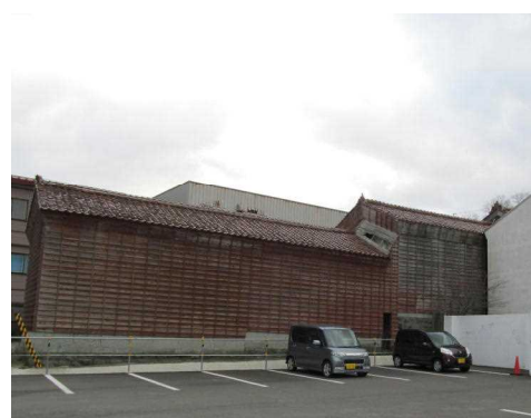
写真3-2 江差町の石州瓦屋根(図3-1のB) (2013年 阿部撮影)
