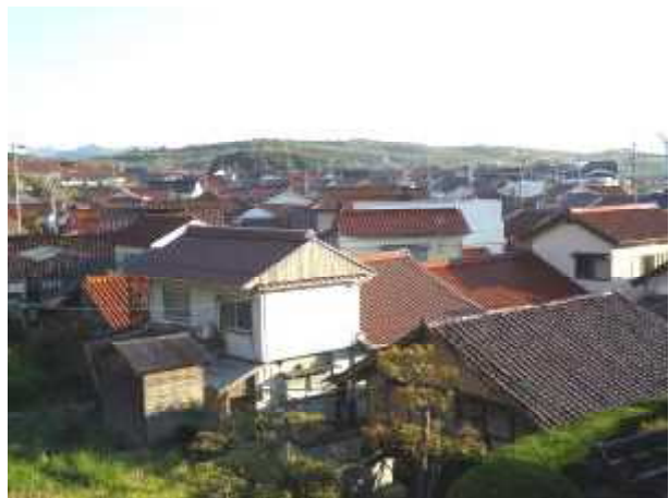
写真1-1 石州瓦の赤瓦景観(江津市波子町)
