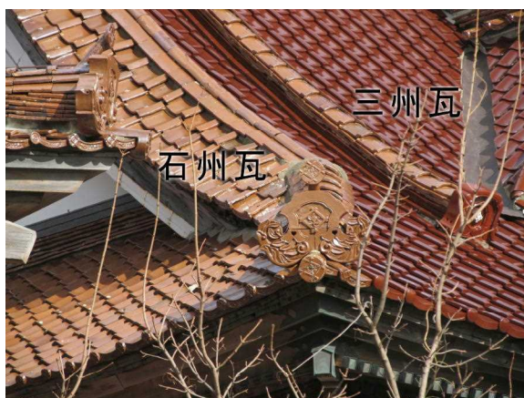
写真4-1-4 北海道松前町で見られる赤瓦の混ぜ葺き (松前町法華寺) ※色も形もサイズも違う異なる産地の赤瓦が同じ屋根に葺かれている 写真左は石州瓦と三州瓦 写真右は屋根から下ろされた越前赤瓦と石州瓦 (阿部撮影 2013年)
