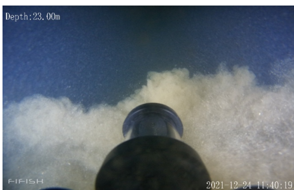
写真 3.10 水中ドローンによる大島ダム内の観測
