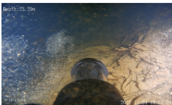
写真 3.11 水中ドローンによる宇連ダム内の観測
