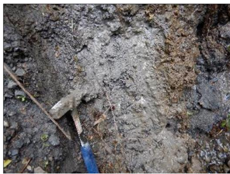
図 2.1.2 地すべり末端に露出する凝灰質泥岩
