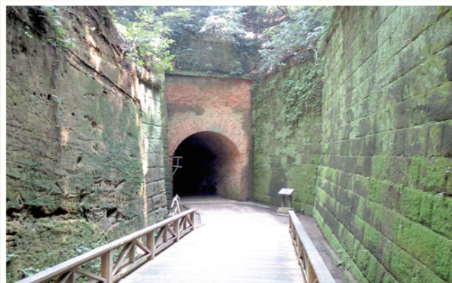
レンガ造りのトンネル
